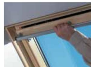
Вентиляционный клапан-форточка совмещен с ручкой для открывания. При установке электрооборудования возможно регулировать величину открывания клапана.
